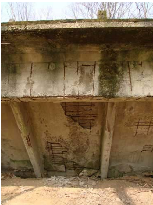
Particolare delle curve sopraelevate nel Parco di Monza
