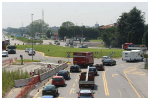
Il "cantiere infinito" sul viale delle Industrie
