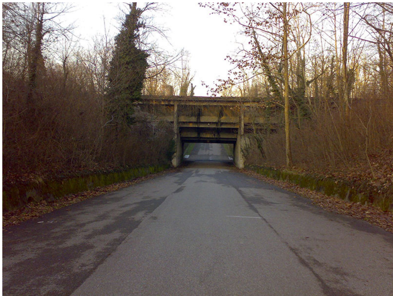
La curva sopraelevata sud che taglia il Viale Mirabello
