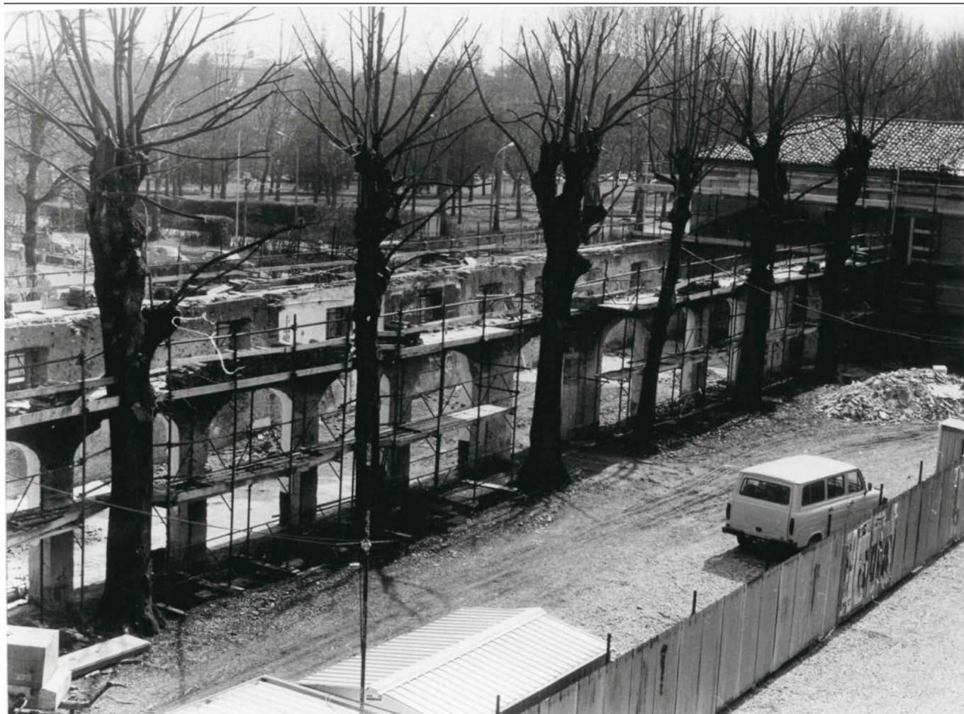
1992-94 ristrutturazione dei laboratori
