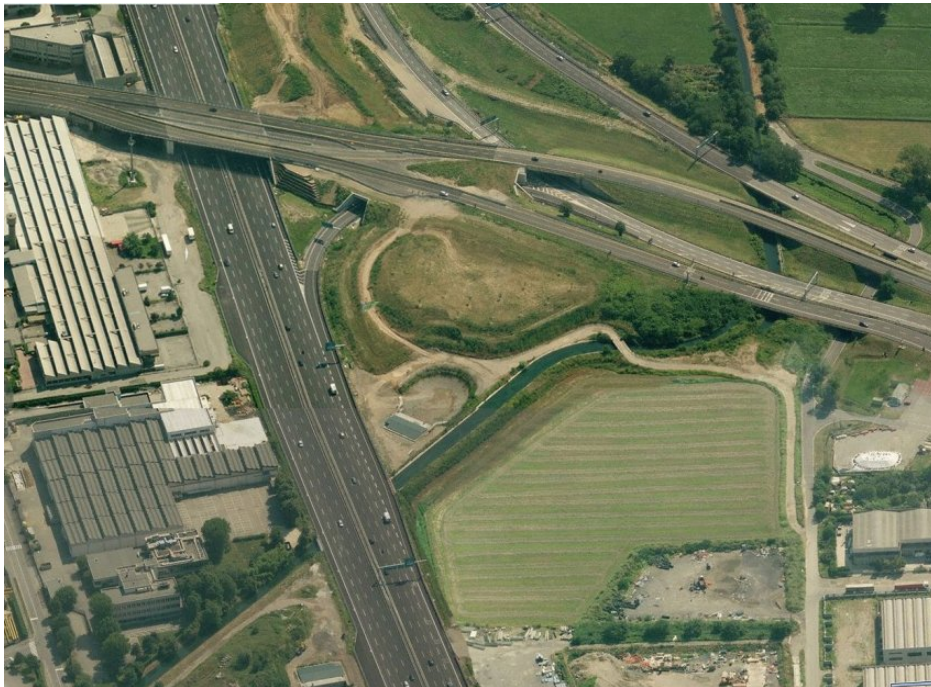
Canale Villoresi: Agrate A4, Milano-Venezia e Tangenziale Est ( foto aerea )
