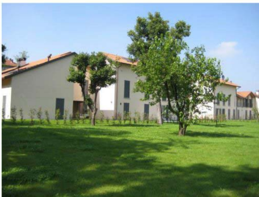
La cascina Cappelletti dopo la ristrutturazione
